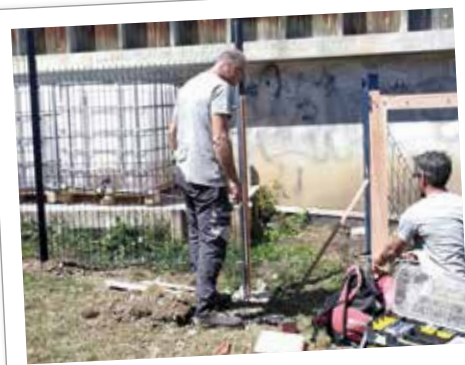
Aménagement autour des cuves de récupération d'eau de pluie pour les jardins partagés du Granjou
