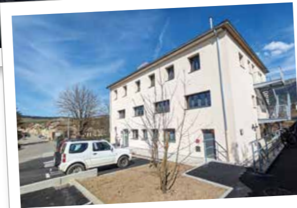
La Maison de santé du pays Mensois est située rue Senebier à Mens. Derrière les façades aux nombreuses ouvertures, le bâtiment affiche une surface de 665 m 2 répartis sur quatre niveaux. Il est alimenté par une chaufferie bois et équipé d'un ascenseur adapté aux besoins des personnes à mobilité réduite.
