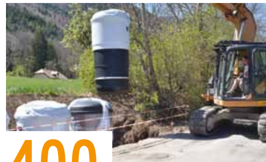
Installation d'une aire à St-Michel les Portes
