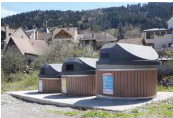
Meilleur rendement et meilleure intégration dans le paysage, l'installation de bacs semi-enterrés sur le Trièves va être conduite entre 2016 et 2017.
